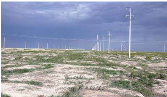
Рис. 4. Трасса нефтепровода КТК с катодной защитой ЛЭП. 05.05.2011. Фото М.В. Пестова
