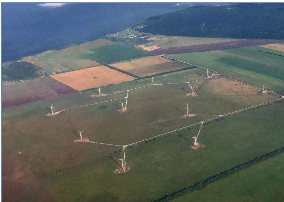
Рис. 5. Общий вид первой очереди Ульяновской ВЭС.
