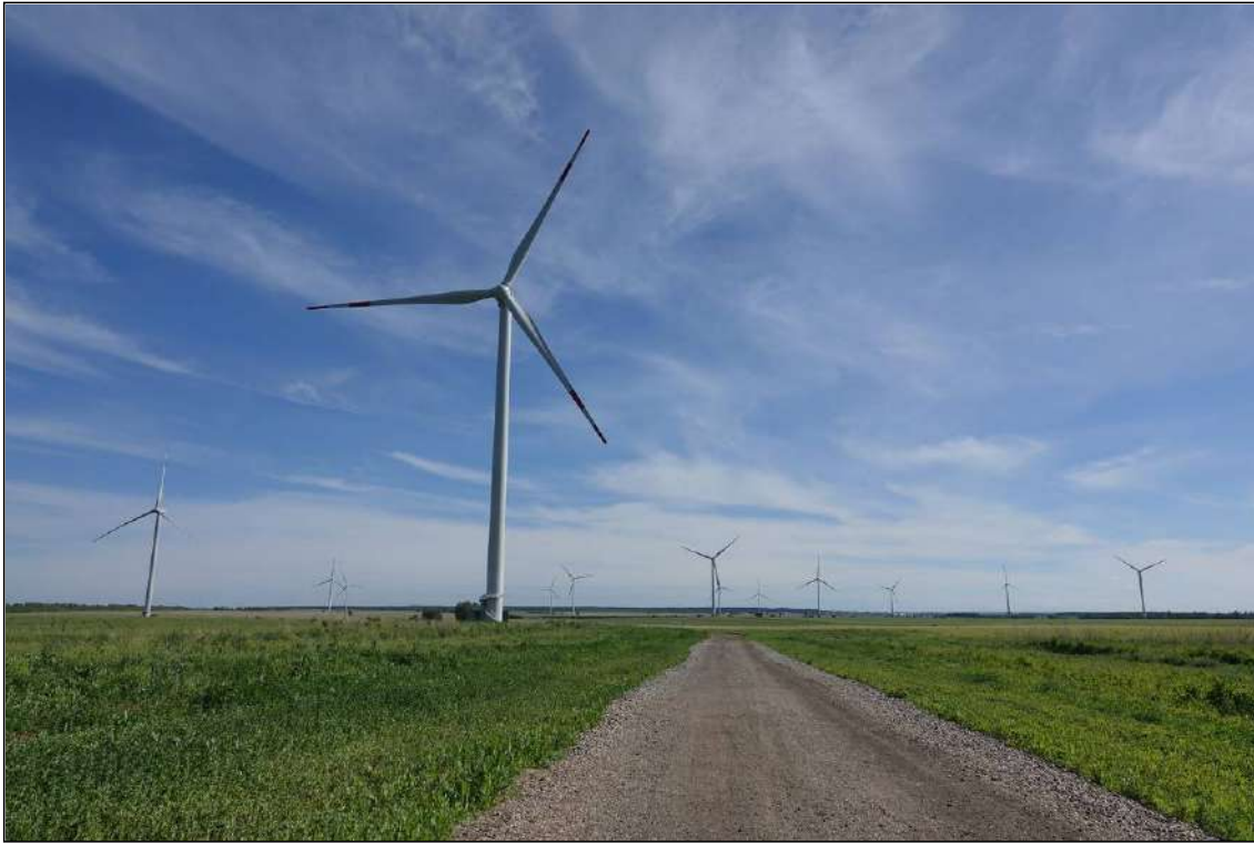
Рис. 1. Общий вид Ульяновской ВЭС. Фото М. Королькова
